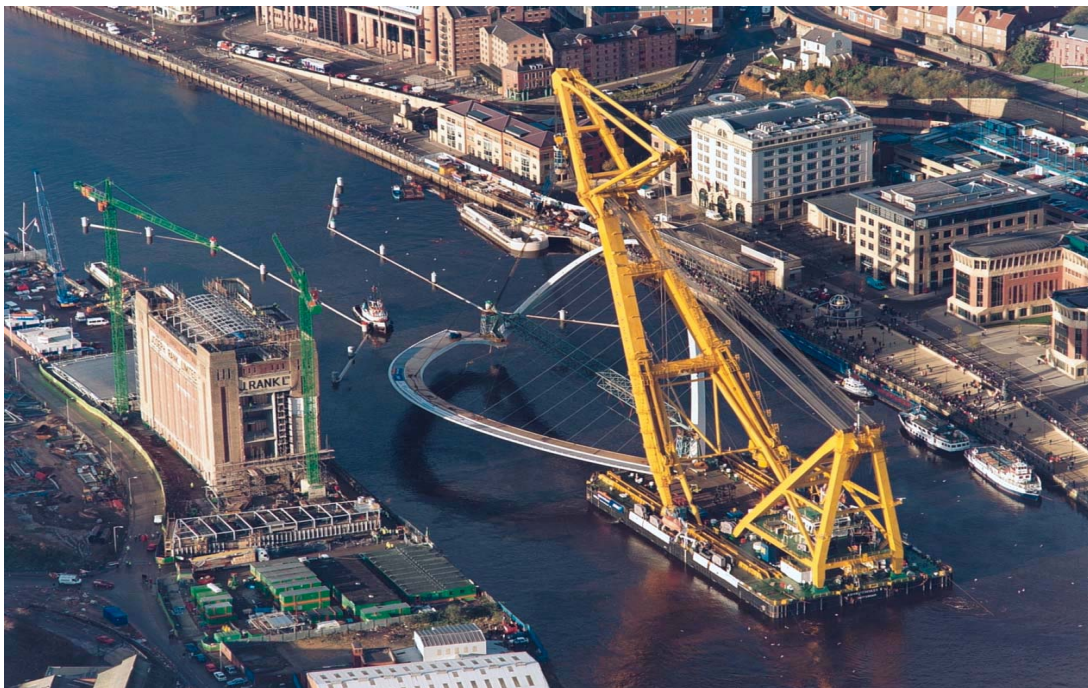
Bild 9 – Transport der Brücke zur Baustelle
